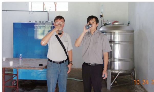
圖7 淨水過濾設備裝設完成後，工作人員試喝第一杯水。
